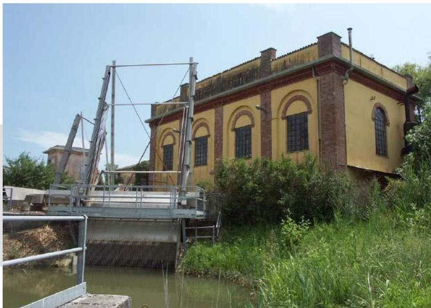
L'edificio ha una pianta rettangolare, è disposto su due livelli. Al piano seminterrato si trovano le camere di raccolta dell'acqua dove sono installate le pompe di sollevamento, al piano rialzato la parte emergente delle 4 pompe e i rimanenti macchinari.
