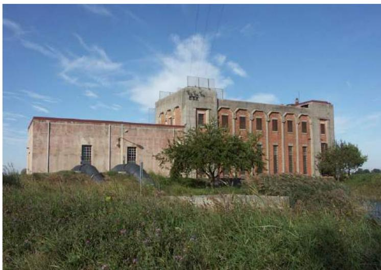
Il fabbricato è a pianta rettangolare ed è disposto su 3 livelli. Nel seminterrato si trovano le camere di raccolta dell'acqua dove sono installate le pompe di sollevamento. Nel piano rialzato è visibile la parte emergente delle 4 pompe centrifughe e i macchinari. Al primo piano c'è l'abitazione dell'idrovorista.
